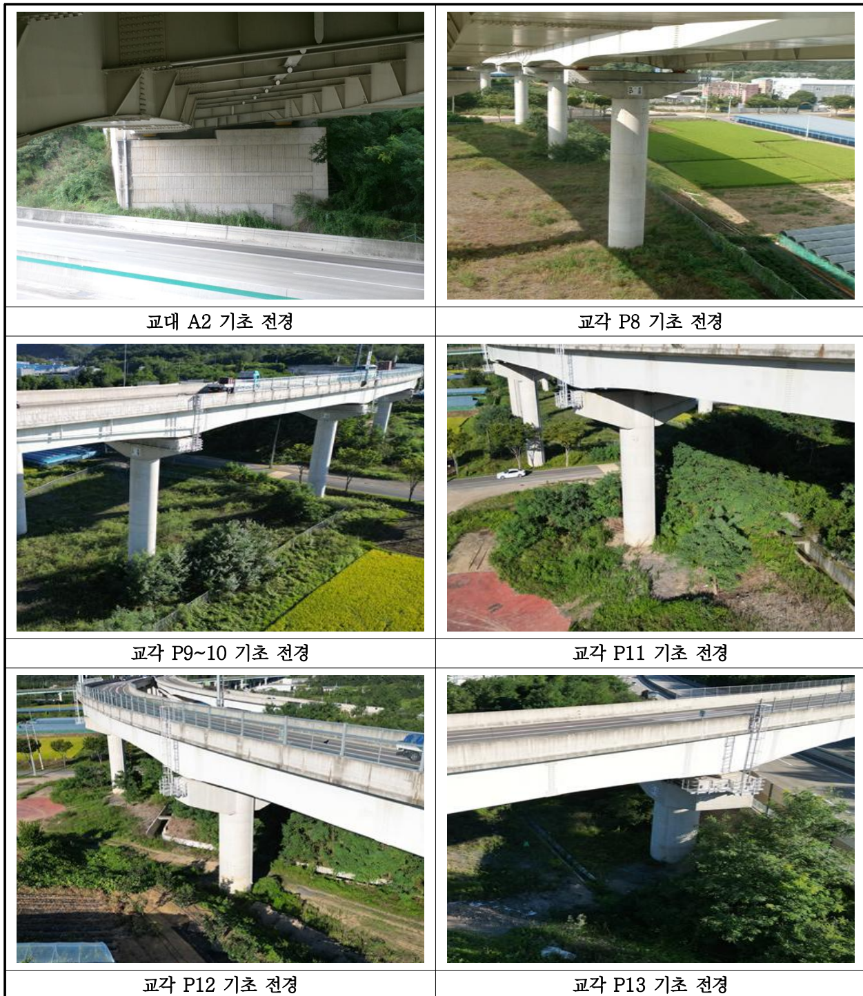
【사진 41.3.12】 기초 전경
