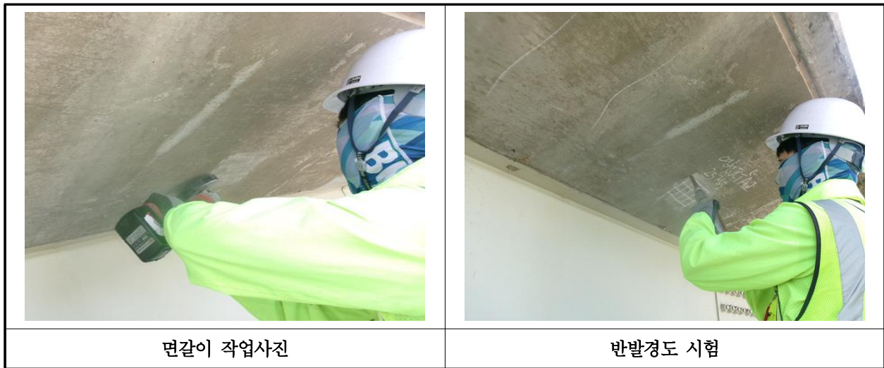
【사진 41.4.2】 반발경도시험 현장사진
