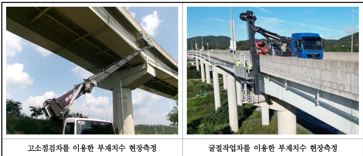
【사진 41.2.1】 부재 현장측정 전경
