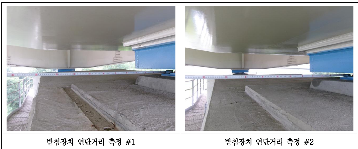
【사진 41.3.14】 교량받침장치 연단거리측정
