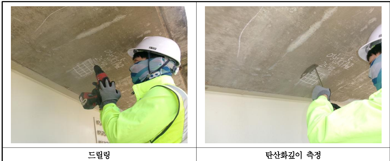
【사진 41.4.3】 탄산화 깊이 측정 현장사진
