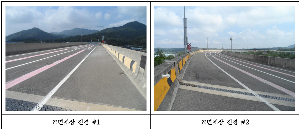
【사진 41.3.19】 교면포장 전경
