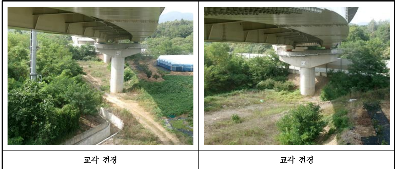
【사진 41.3.10】 교각 전경
