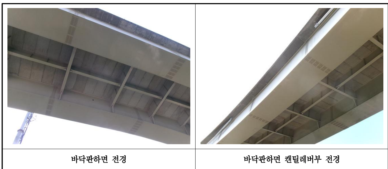
【사진 41.3.2】 바닥판하면 전경
