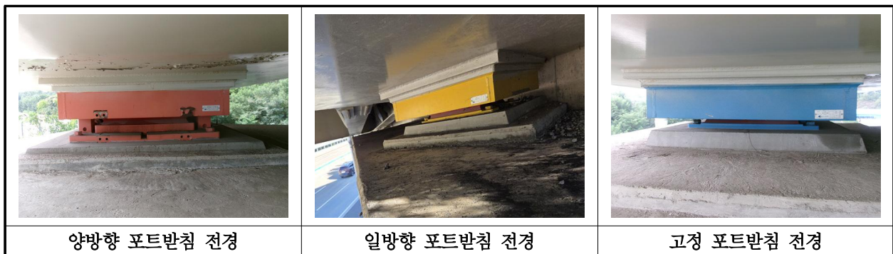
【사진 41.3.12】 교량받침 전경
