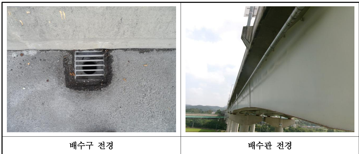
【사진 41.3.21】 배수시설 전경
