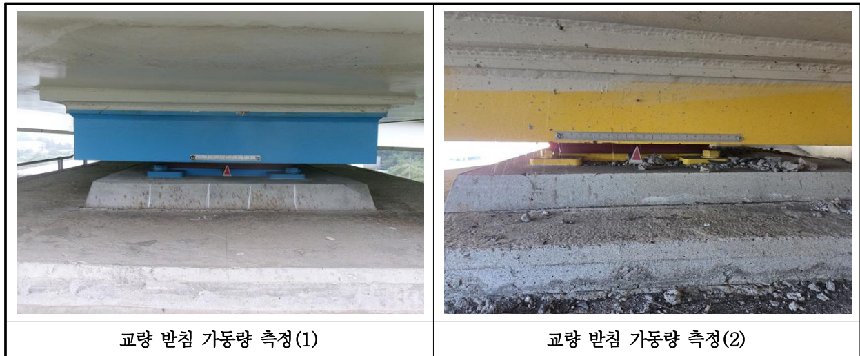
【사진 41.3.15】 교량받침 이동량 측정
