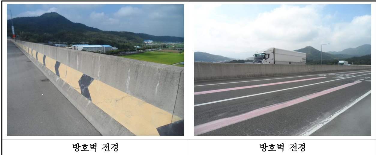
【사진 41.3.23】 방호벽 전경
