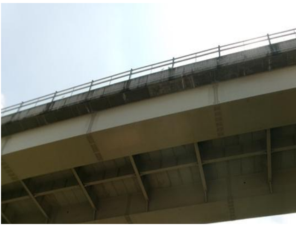
바닥판하면 S11 캔틸레버 상태현황
