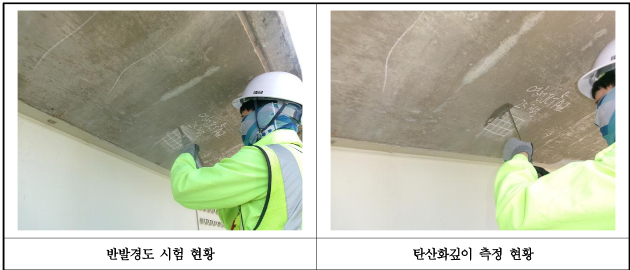
【사진 41.4.1】 콘크리트 내구성조사 현황
