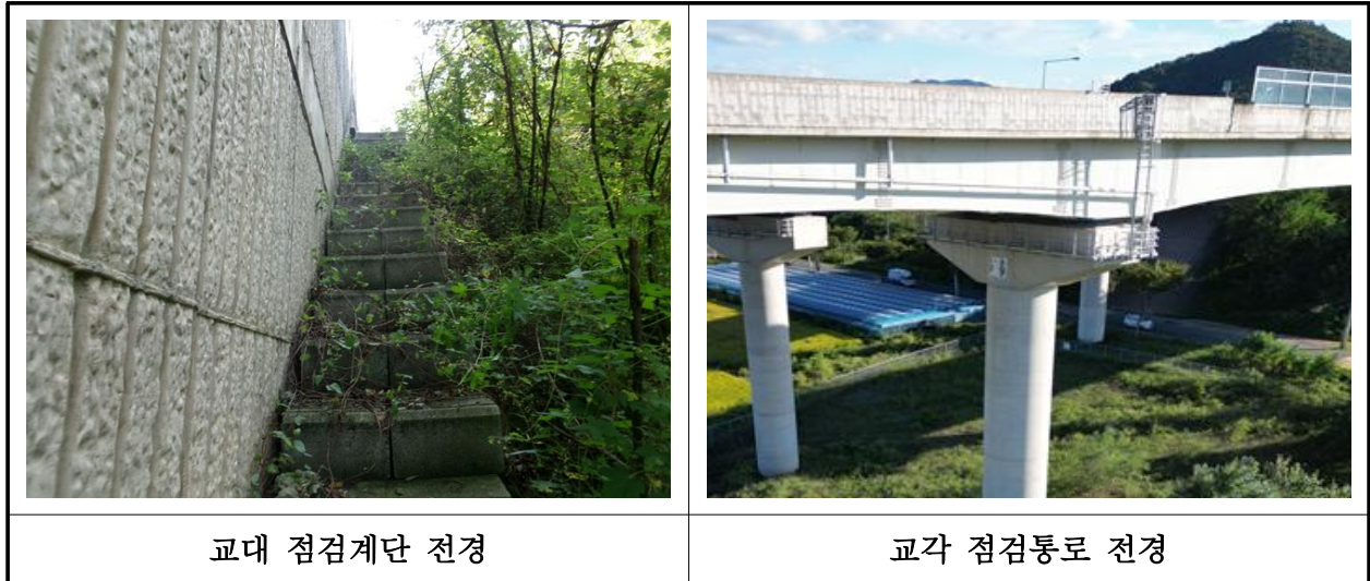
【사진 41.3.25】 교량 점검시설 전경
